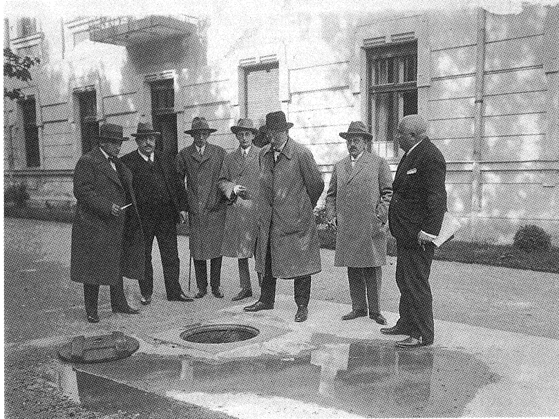
Nyomozócsoport fotója, a vélt bűnelkövetési helyszín, a nyitott csatornafödél felett. A kép közepén Tábori Kornél áll OSZK Kézirattár, Tábori-hagyaték
