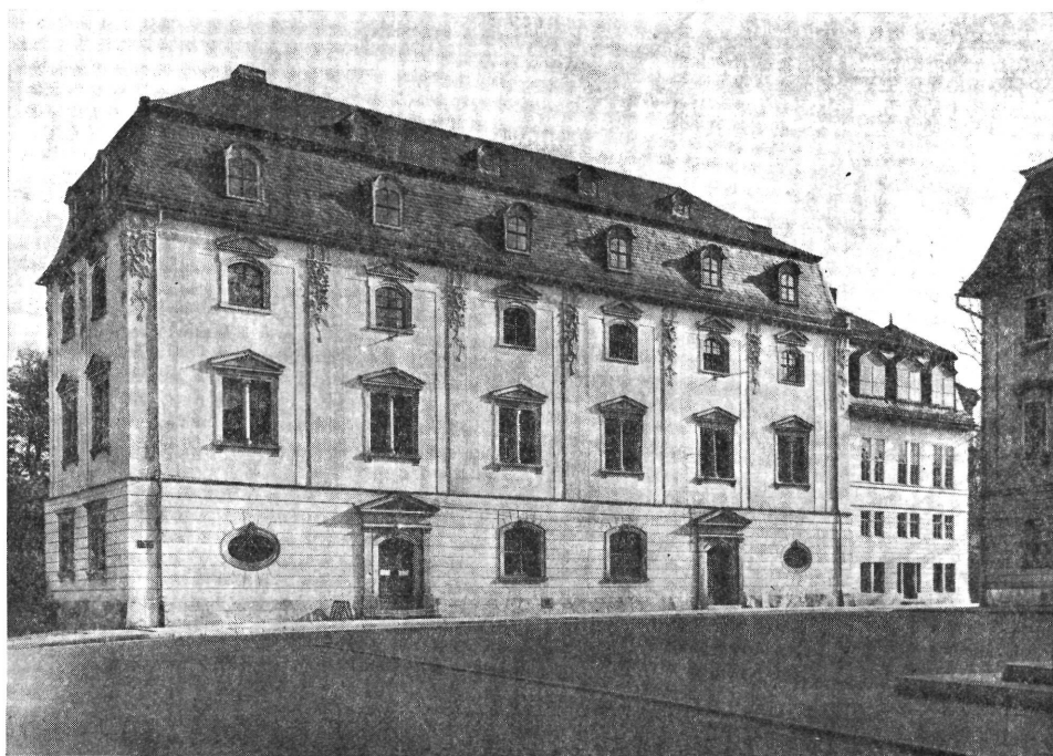
1. Abb. Bibliotheksgebäude von 1560 bzw. 1761/66 mit nördlichem Anbau (links) und Goethe-Anbau (rechts)
