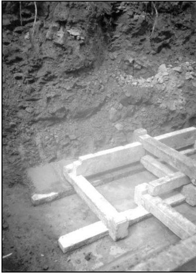
31. ábra A rétegvíz „befogásának” előkészítése a támszerkezet baloldali részén
