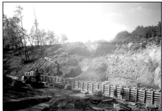
36. ábra A támszerkezet a rézsűkárosodás hosszában, szerelés közben
