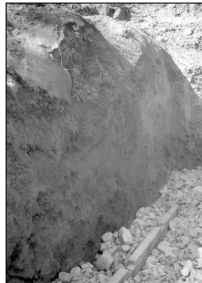
35. ábra A szárítóborda terméskővel történő kitöltése a föld felületéig
