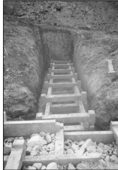
34. ábra A szárítóborda csatlakozása a támasztó szerkezethez, szerelés közben
