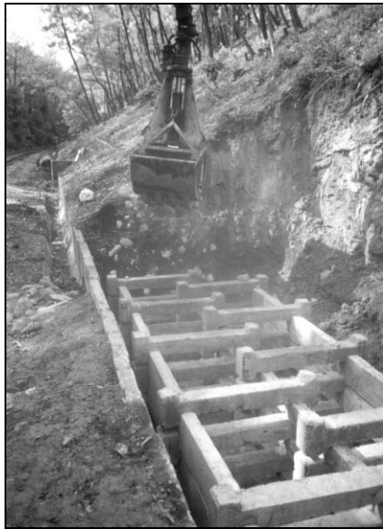
32. ábra Az előregyártott vasbeton elemek szerelése az alapozásnál
