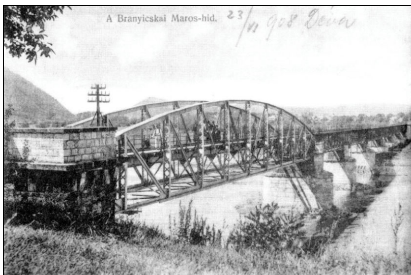
4. ábra A branyicskai Maros-híd vasszerkezetre átépített része
