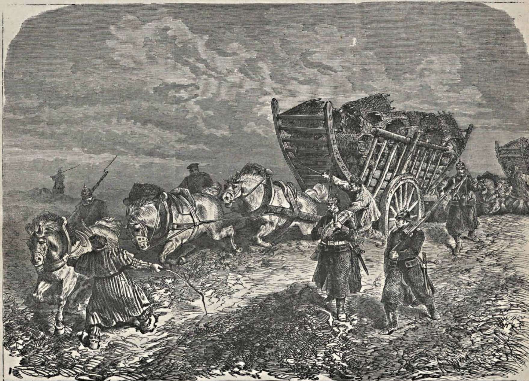
Porosz sánckosarak szállítása a párisi ostromművekhez.
