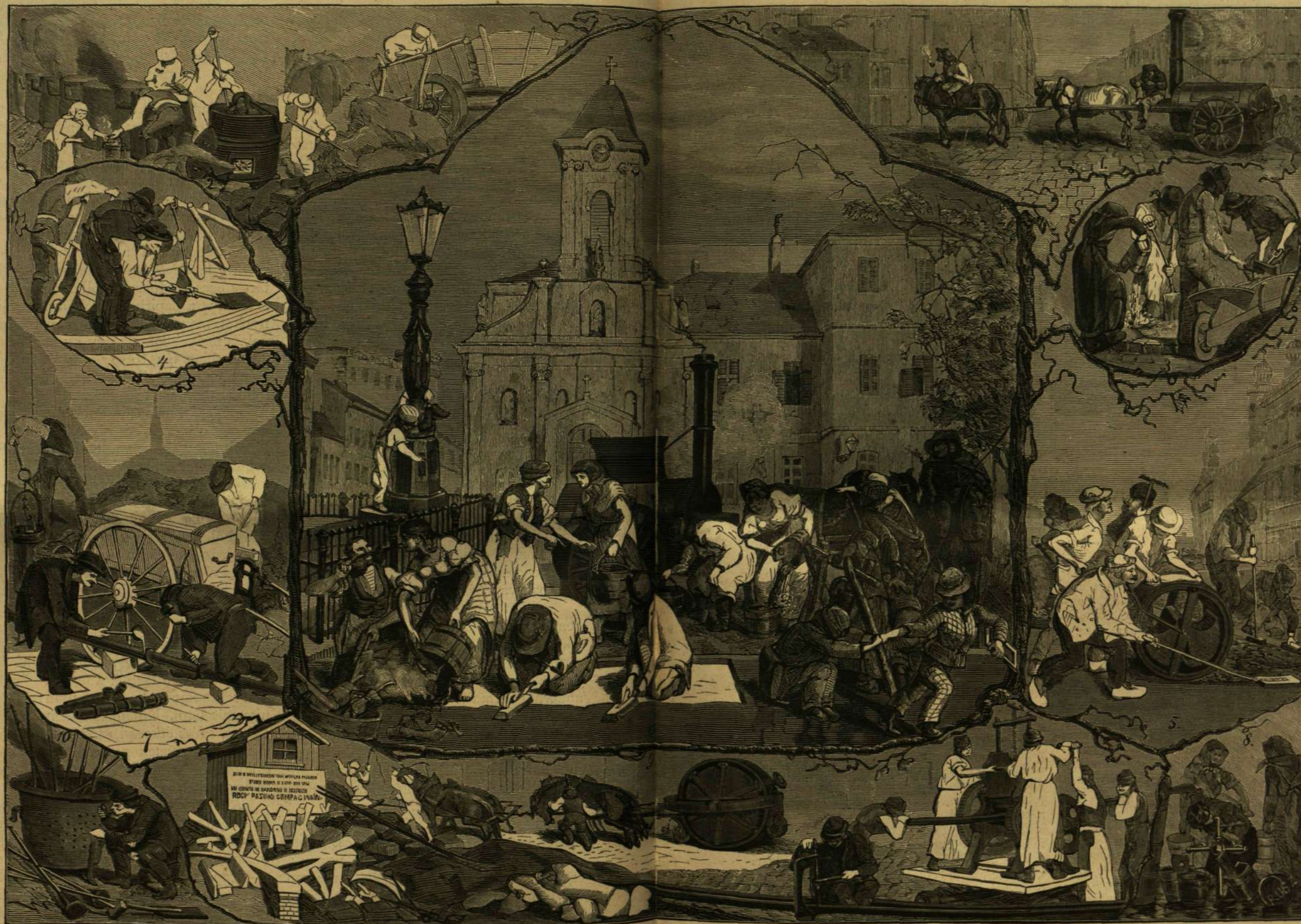
ASZFALT-BURKOLAT KÉSZÍTÉSE A KEREPESI-UTON.
