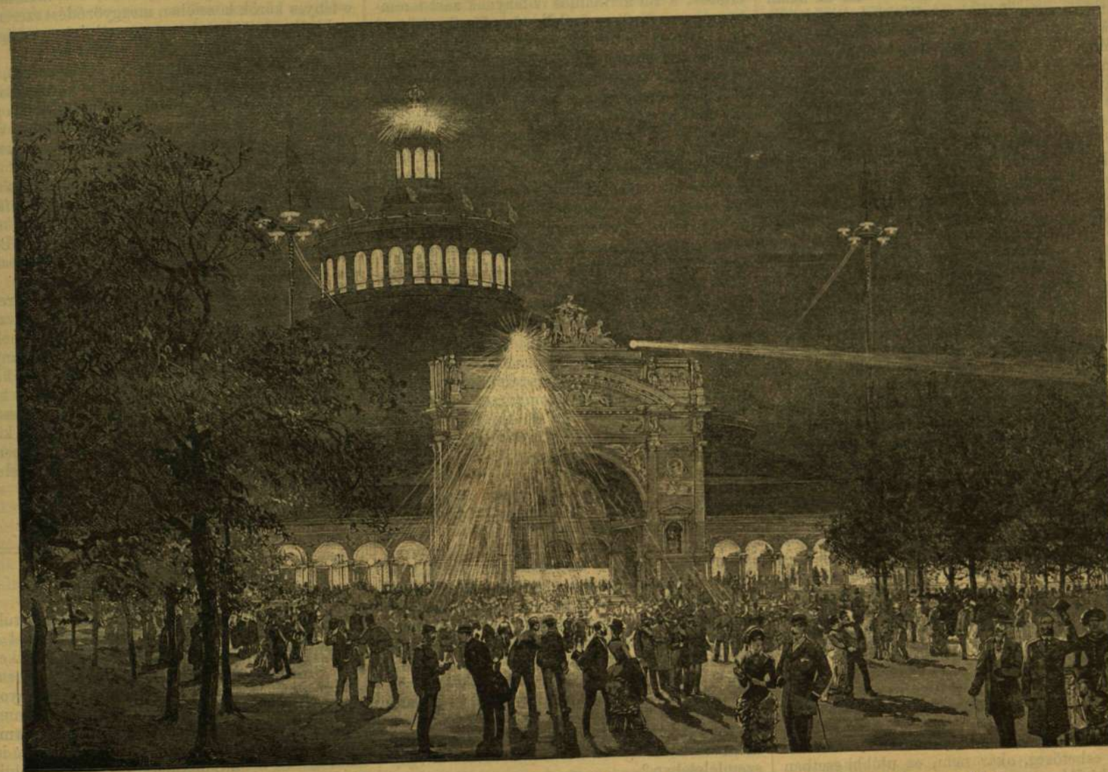
A BÉCSI NEMZETKÖZI VILLAMOS KIÁLLITÁSRÓL. — A ROTUNDA ELŐTTI TÉR VILLAMOS KIVILÁGÍTÁSA.
