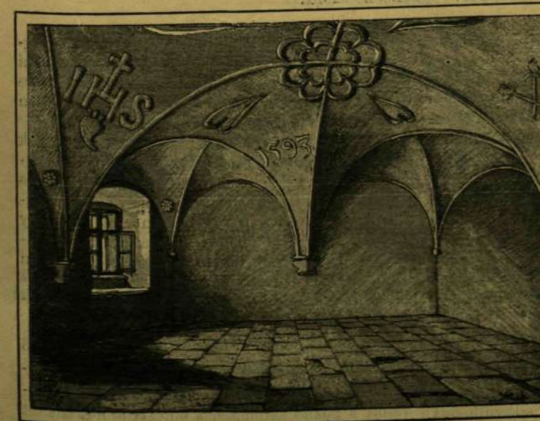
FÖLDSZINTI SZOBA A ZRÍNYI-VÁRALJAI APÁTSÁGI ÉPÜLETBEN.
