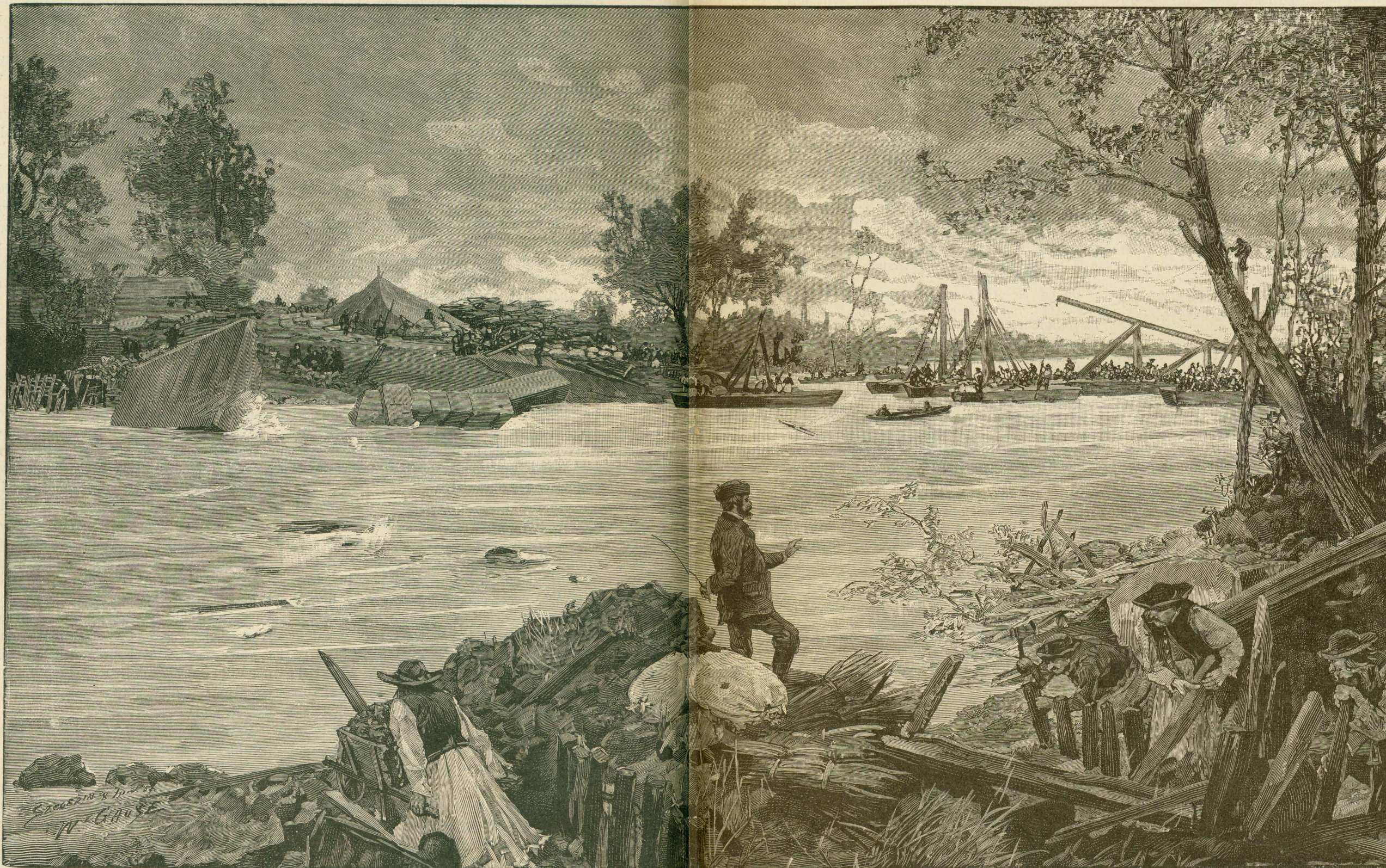
A TISZAI ÁRVIZ. — GÁTSZAKADÁS A KIS-TISZAI ZSILIPNÉL. VÉDEKEZÉSI MUNKÁLATOK.
