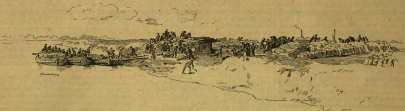
FÖLDES ZSÁKOK SZÁLLÍTÁSA A KIS-TISZAI SZAKADÁSHOZ.
