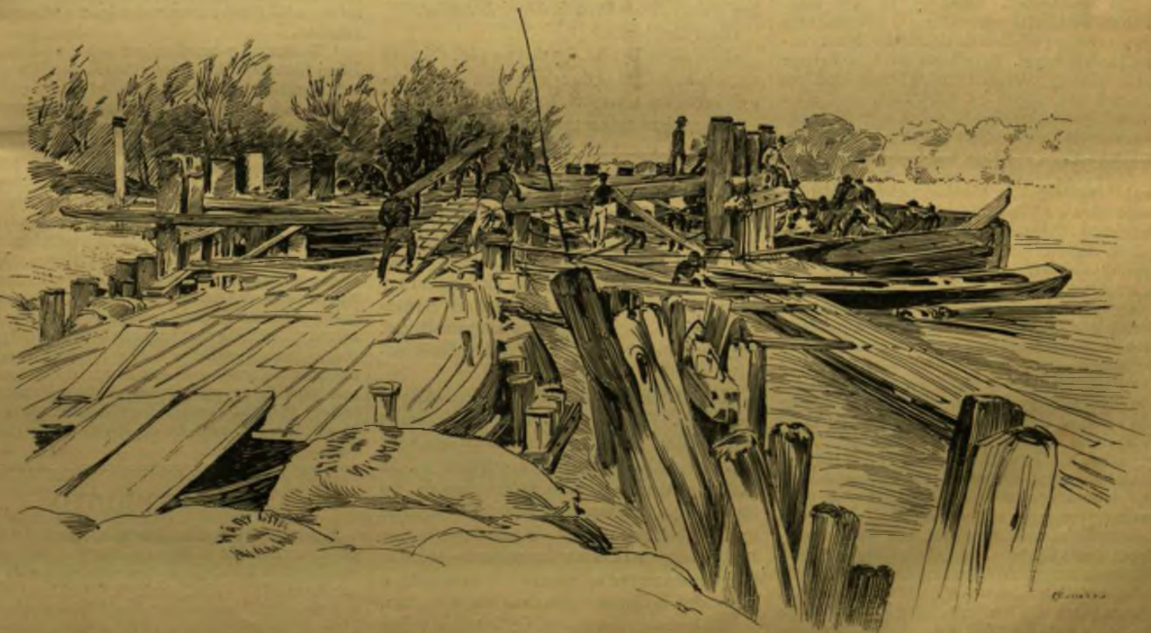
BETÖMÉSI MUNKÁLATOK A KIS-TISZAI SZAKADÁSNÁL.
