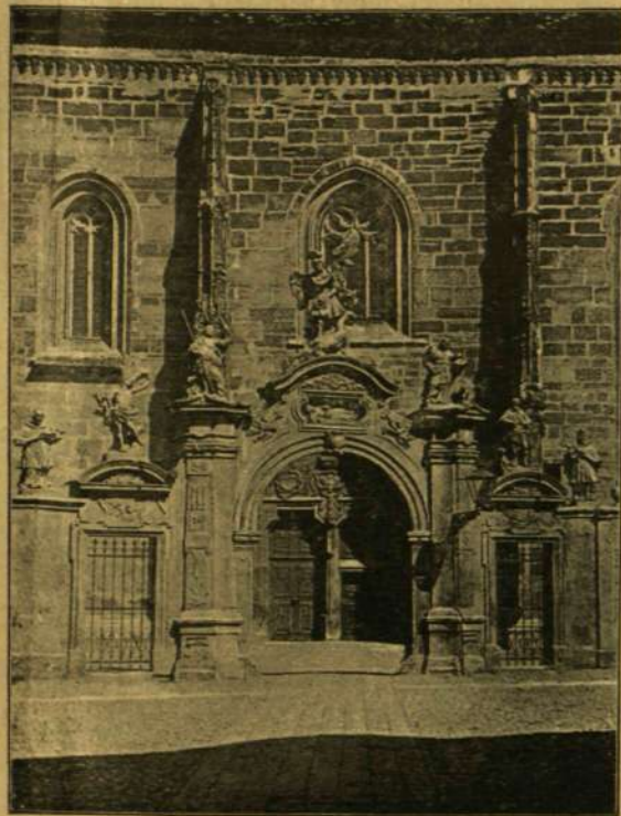
A FÖTÉRI PLÉBÁNIA-TEPLOM BEJÁRATA.
