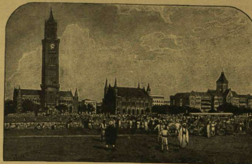
KÖZÉPÜLETEK AZ ESPLANADE-ON BOMBAYBAN.
