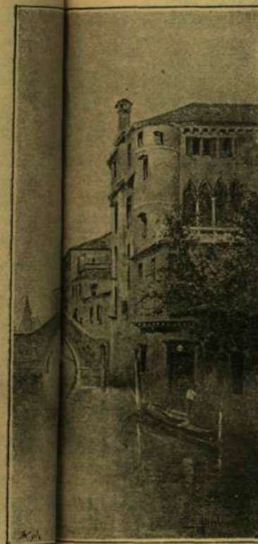
A. Vélczei csatorna.
