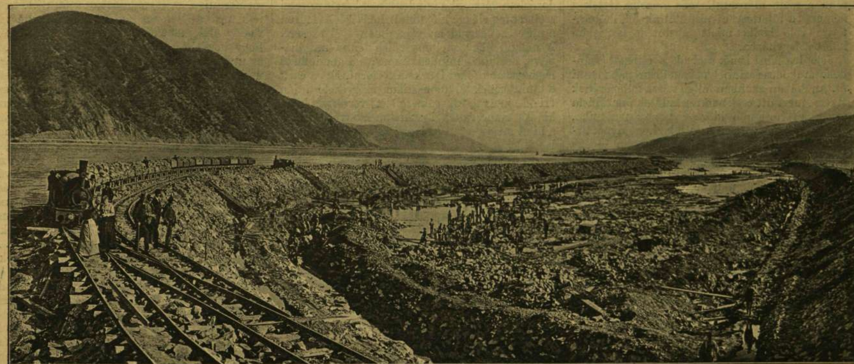
A Vaskapu-csatorna fejkének lemélyítése.
