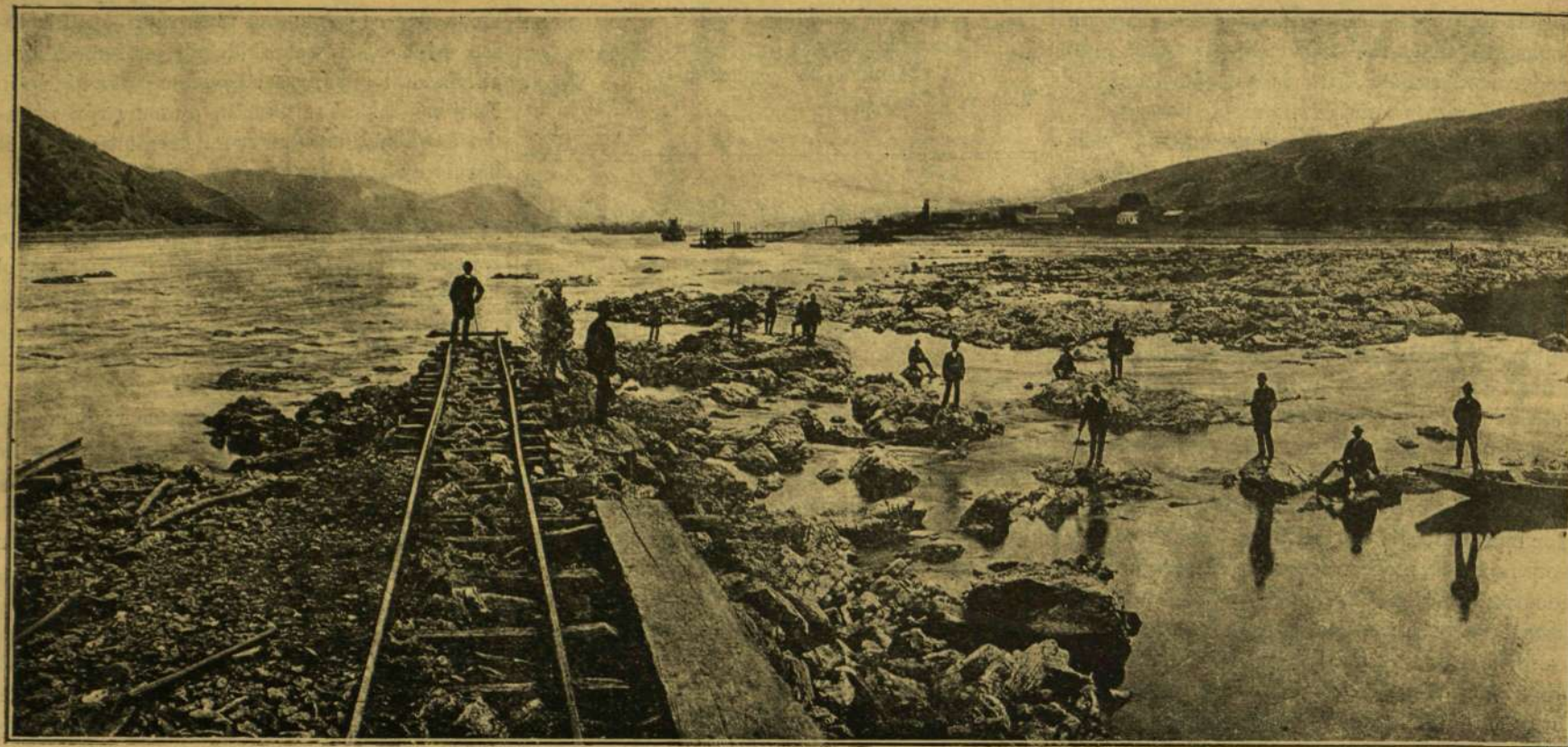
A Vaskapu-csatorna baloldali vezérgátja eléri a Plócsia szirtjeit.
