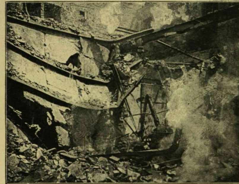
A szárító-telep szétróbbant kazánja.
