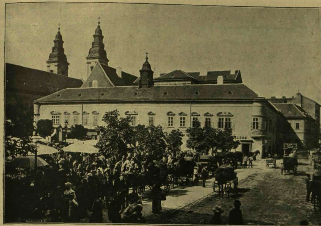
A PIARISTÁK ÉPÜLETE A VÁROSHÁZTÉREN.
