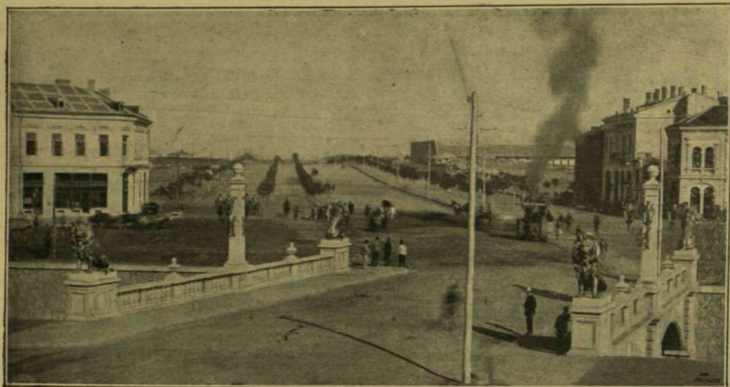
A LOMPALANKAI BOULEVARD A VASÚT FELÉ.
