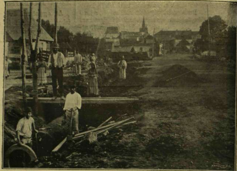
BETON CSÖVEK LERAKÁSA AZ ÚJ 'KIRÁLY-UTCA'-BAN.
