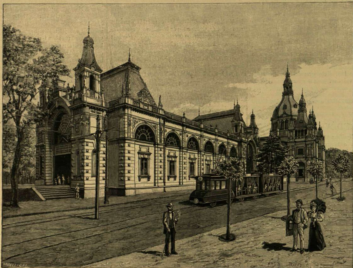
AZ EZREDÉVI KIÁLLÍTÁSBÓL. — A KÖZLEKEDÉSI CSARNOK.
