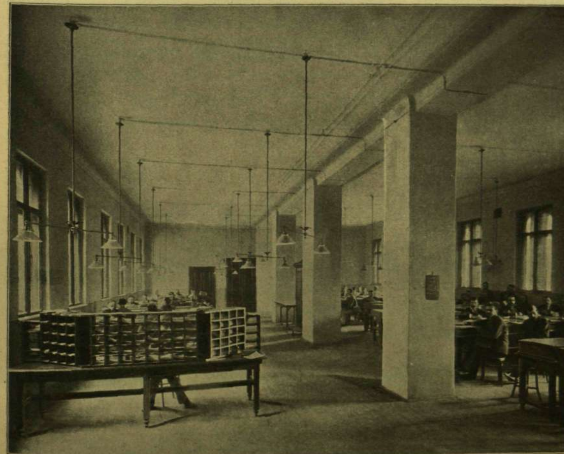
KÉZBESÍTŐK TERMÉ A VERSENY-UTCAI POSTAKEZELÉSI ÉPÜLETBEN.
