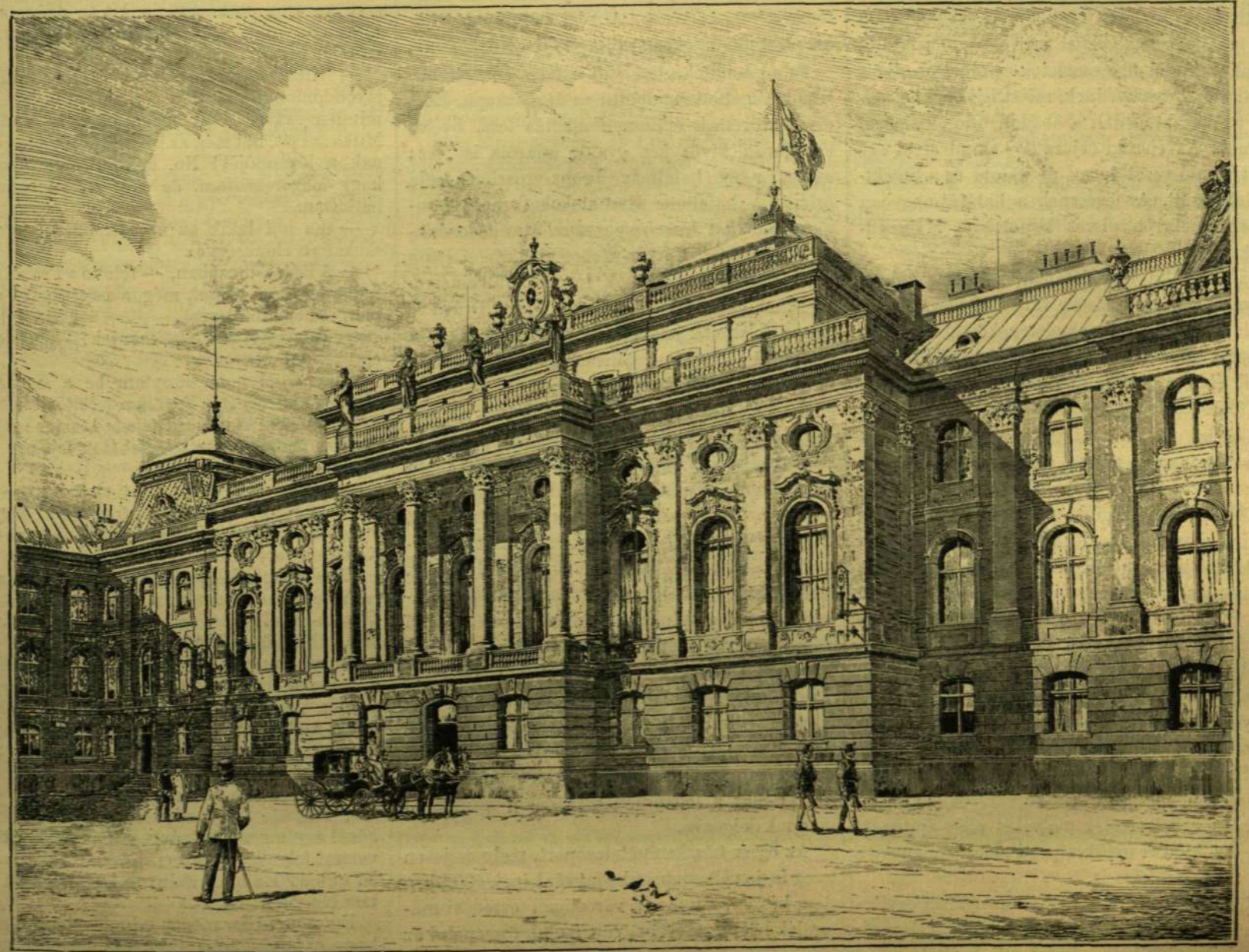
A BUDAI KIRÁLYI PALOTA ÉPÍTÉSE. — Az új udvari homlokzat, a hol a trüsterem van.
