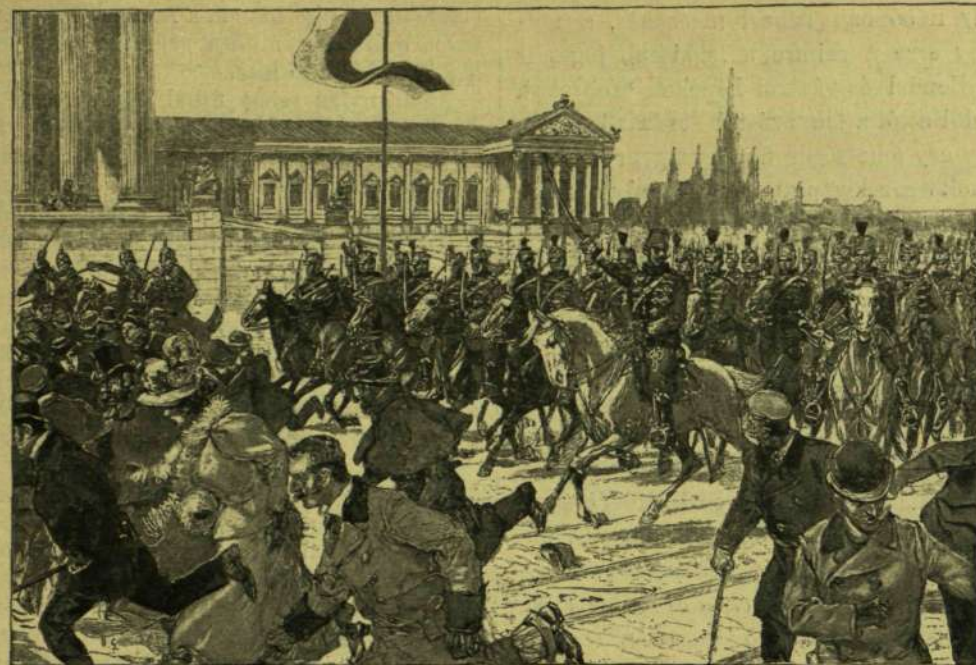
A BÉCSI ZAVARGÁSOK. — A huszárok rohama a zavargók ellen a képviselőház előtt.
