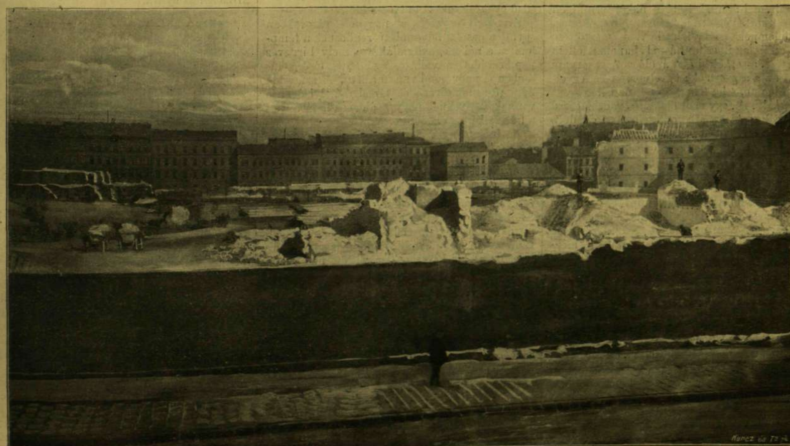
AZ ÚJ-ÉPÜLET HELYE A LEBONTÁS UTÁN, A NÁDOR-UTCÁBÓL NÉZVE.
