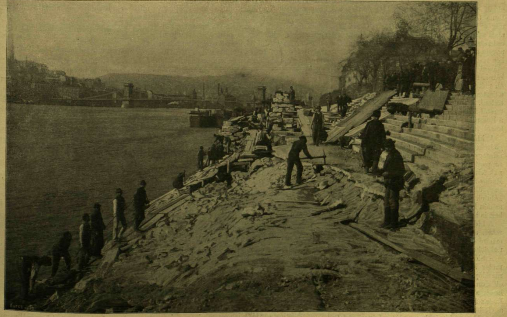
AZ ESKÜTÉRI HÍD ÉPÍTÉSE. — A HIDÉPÍTÉS KEZDŐ MUNKÁLATAI A PESTI DUNA-PARTON. Erdélyi fényképe után.
