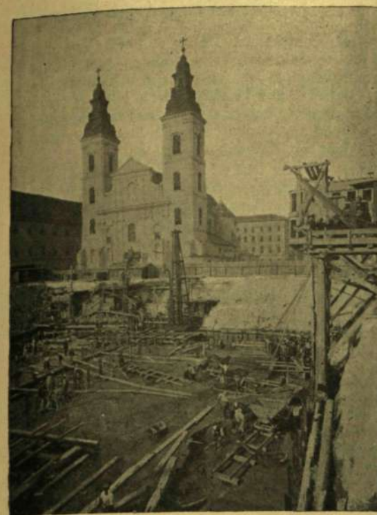
AZ ESKÜTÉRI HÍD ÉPÍTÉSE. — A pesti hídő alapozása.
