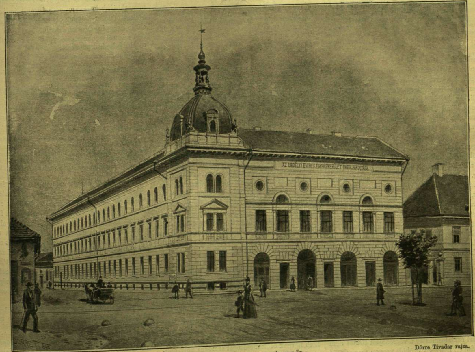
A FÜHOMLOKZAT A TRENCIN-TÉR FELŐL.
