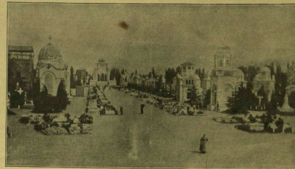
FŐ-ÚT A MILÁNÓI «CIMITERIO MONUMENTALE»-BAN.
