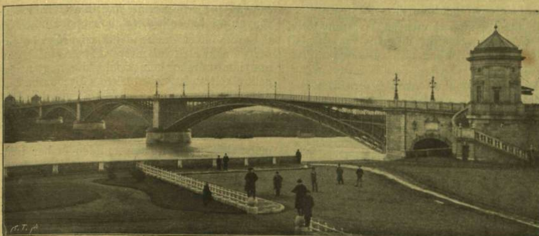
A KÖZLŐ HÍD.
