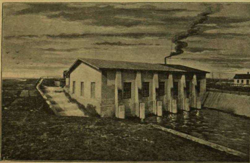
A TURBINA-HÁZ AZ ALSÓ MŰCSATORNA FELŐL.
