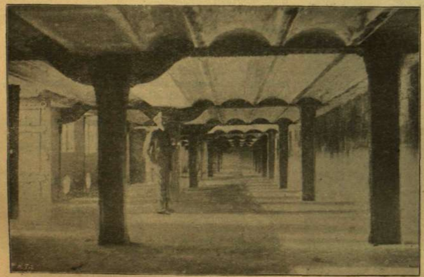
A viadukt atja.
