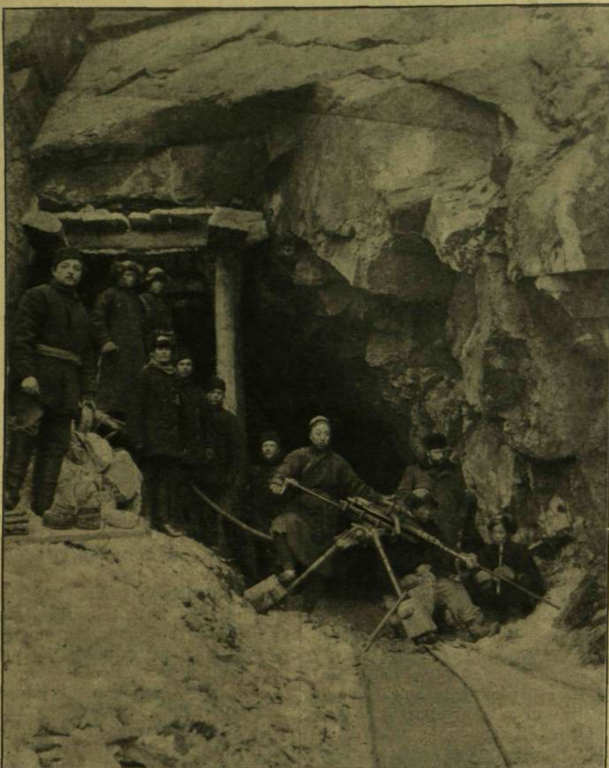
Gubányi amerikai sziklafúrója a mandsu-orosz vasút alagútjainak építésében.
