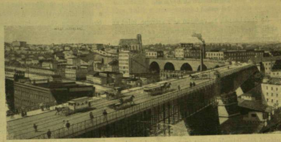
CLEVELAND VÁROS A VIADUKTAL.
