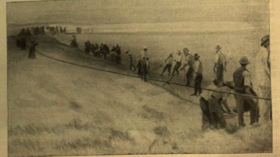
A földköri táviró-kábel lefektetése a szárazföldön, Southport mellett Ausztráliában.
