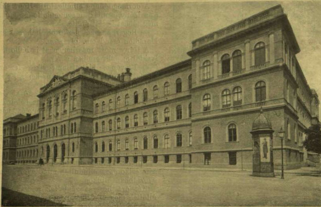
A KÖZPONTI ÉPÜLET FŐHOMLOKZATA.
