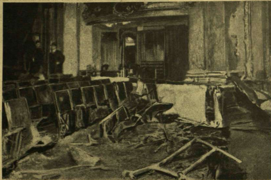
A NÉZŐTÉR JOBBOLDALI FÖLDSZINTI RÉSZÉ A TŰZ UTÁN.
