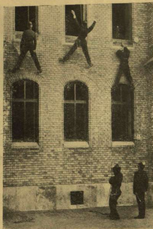
A tűzoltó kötélén fölhúzzák a ház falára.
