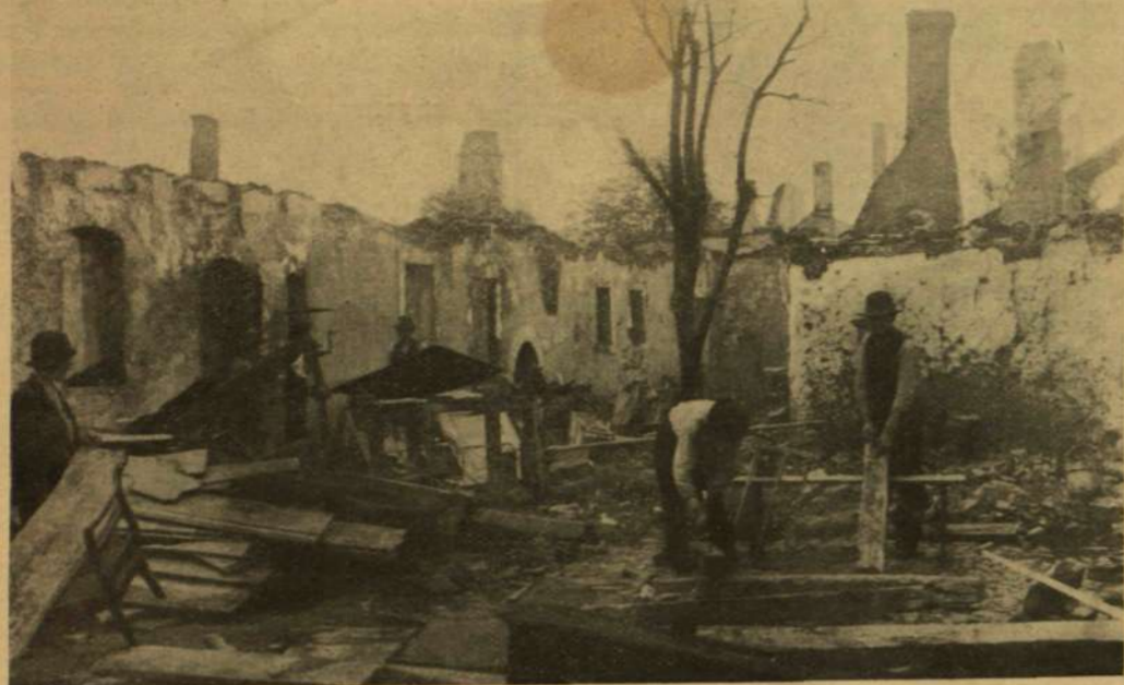
EGY LEÉGOTT HÁZ UDVARA, MELYBEN AZ ÉPÜLETEK IDEIGLENES BEFEDÉSÉN DOLGOZNAK.
