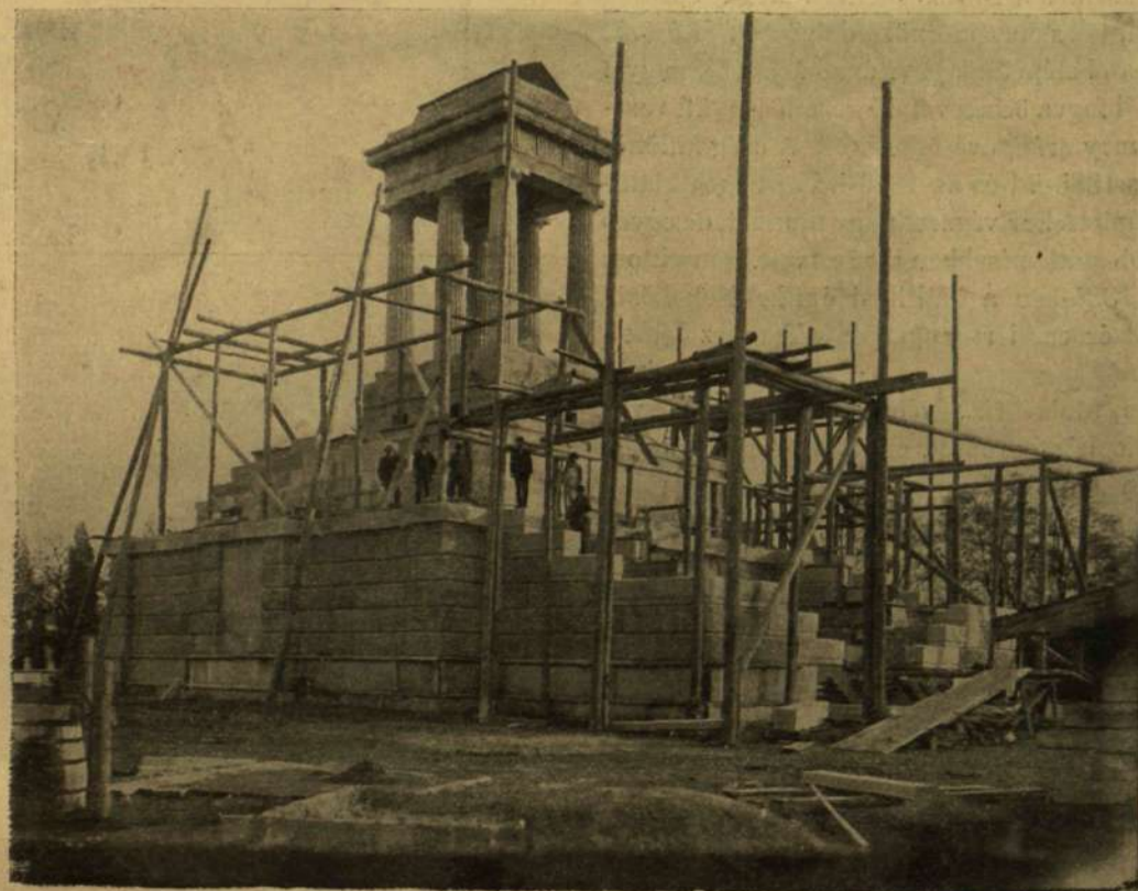
KOSSUTH MAUZOLEUMÁNAK ÉPÍTÉSE A KEREPESI-ÚTI TEMETŐBEN.
