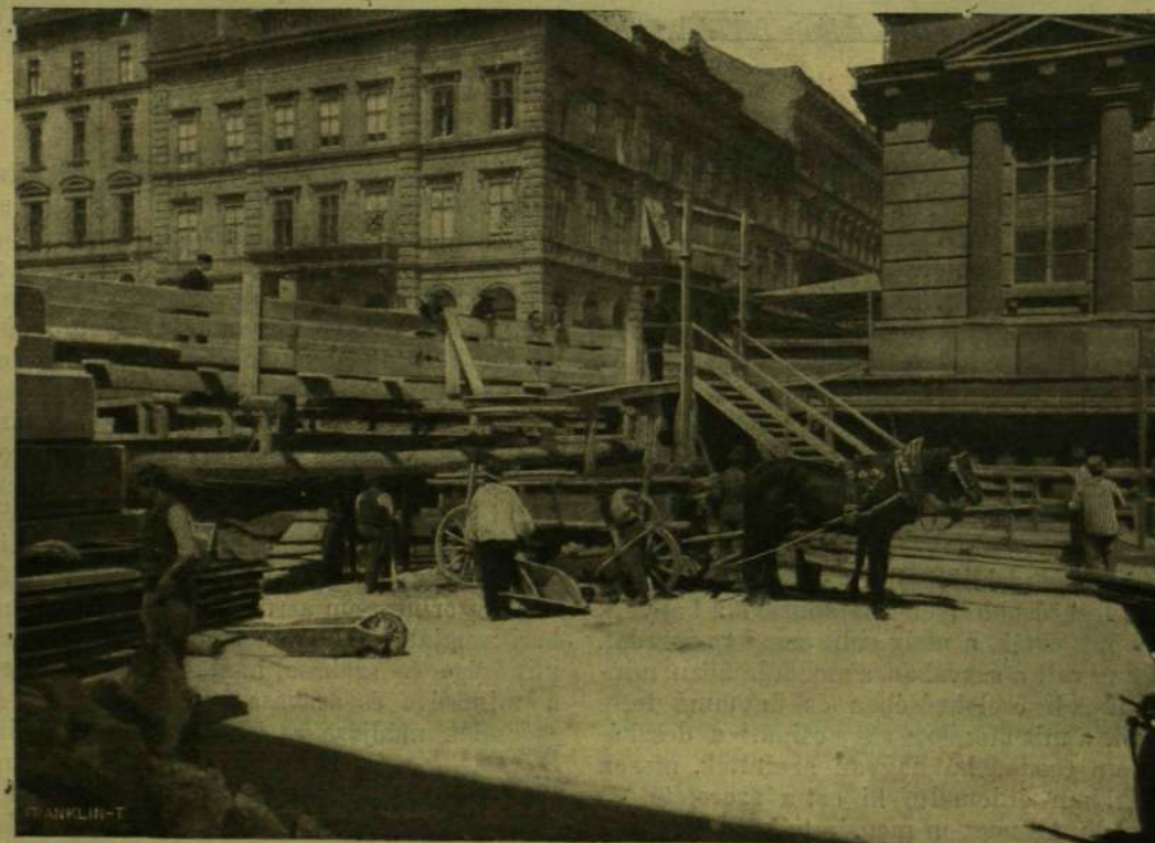
A BUDAI DUNAPARTI VILLAMOS VASÚT ÉPÍTÉSE A LÁNCZHÍDNÁL.
