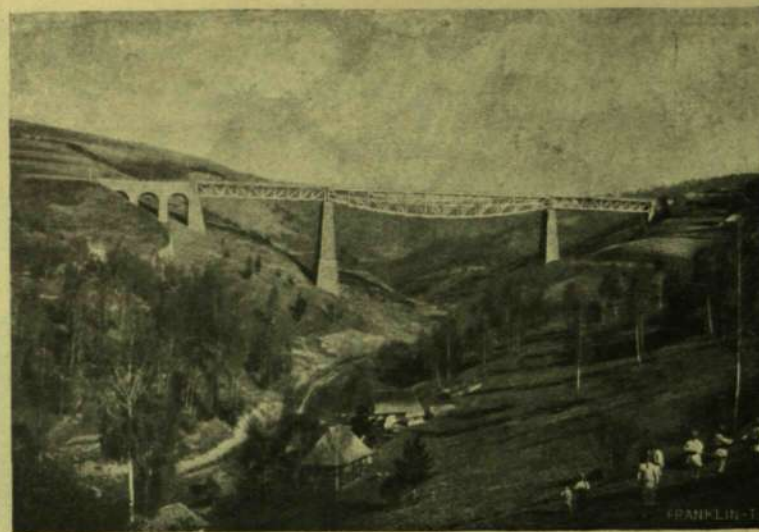
KARAKÓI VASÚTI VIADUKT.
