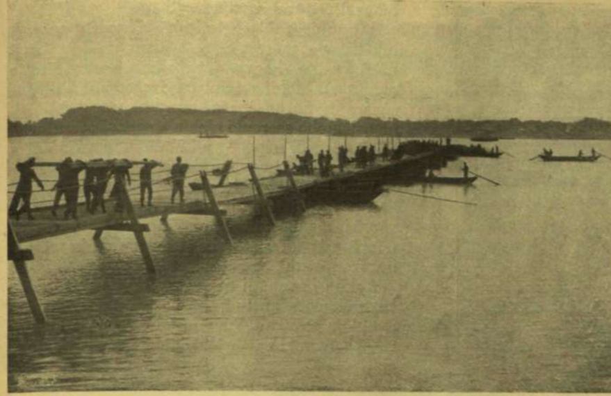
A HID ÖSSZEÁLLÍTÁSA.
