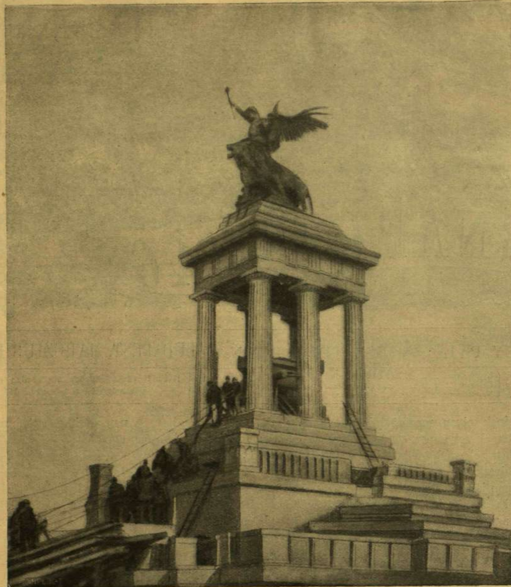
KOSSUTH MAUZOLEUMA ÉPÜLŐBEN.
