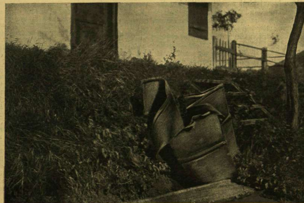
A ROBBANÁS ÁLTAL FELSZAKÍTOTT HÍDFŐ LEMEZ.
