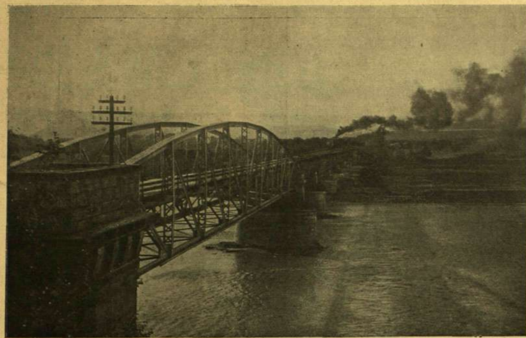
A VASÚTI HÍD A DÉVA FELŐLI OLDALRÓL.
