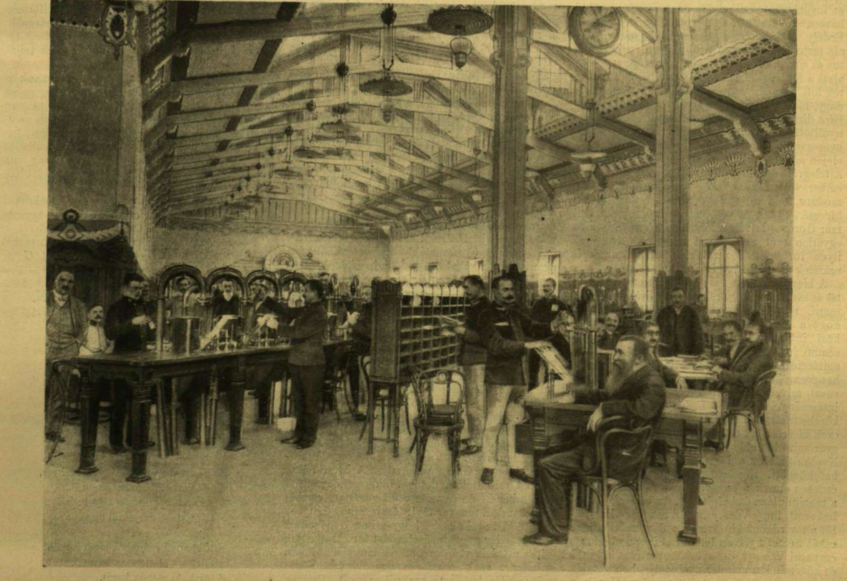
A BUDAPESTI ÚJ TÁVIRDA-KÖZPONT. — IRÁNYÍTÁS, CSŐPOSTA FŐÁLLOMÁS.
