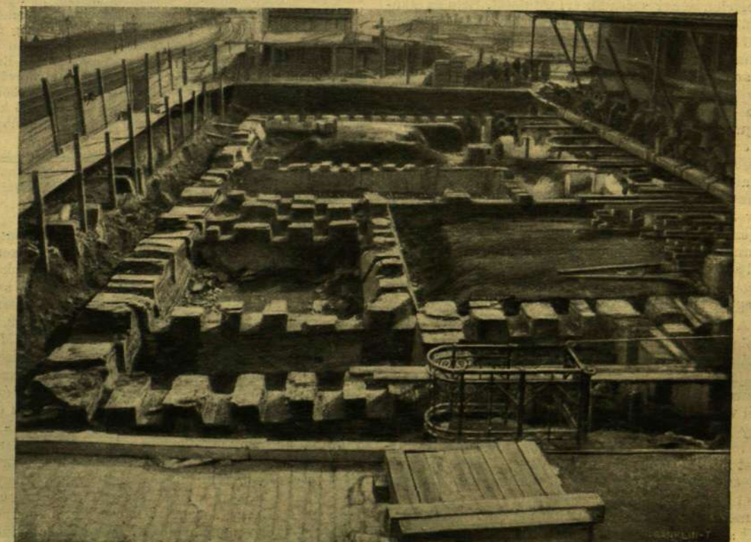
AZ ALAPFALAK, MELYEKEN AZ ÉPÜLET ÁLLT, AZ ELTOLÁSI PÁLYÁVAL S A VÍZVEZETÉKI CSŐ-TOLDÁSOKKAL.
