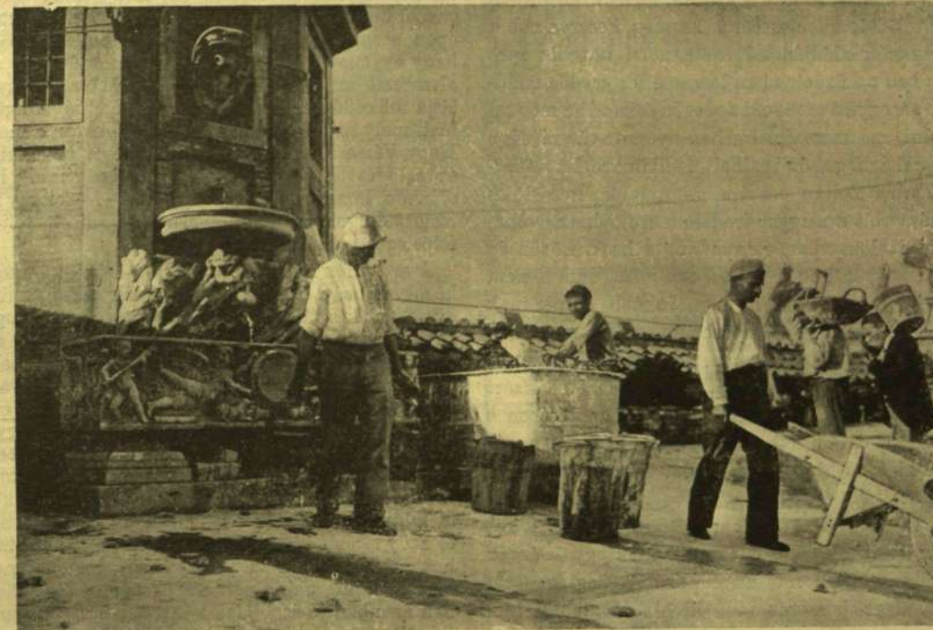
CSURGÓ-KÚT A TETŐ FÖLÖTT.
