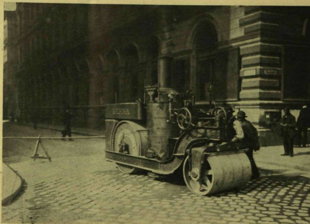
UTÓZAJVÍTÁS A FŐVÁROSBAN. — Aszfalt-hengerelő gézgép.
