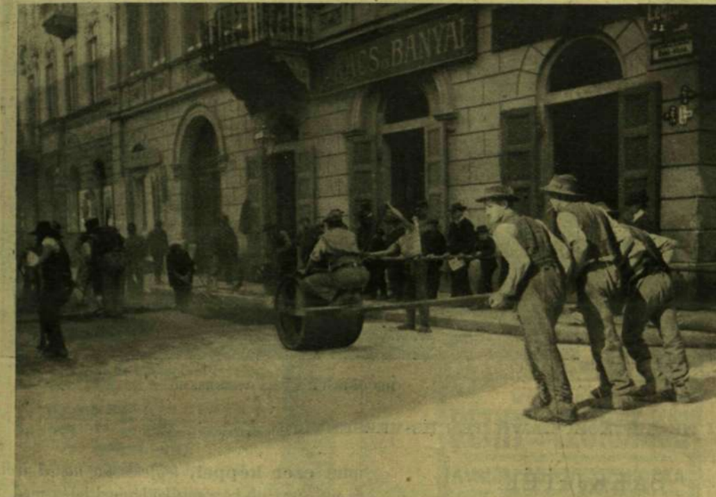
PRÉSELT ASZFALT HENGERELÉSE.
