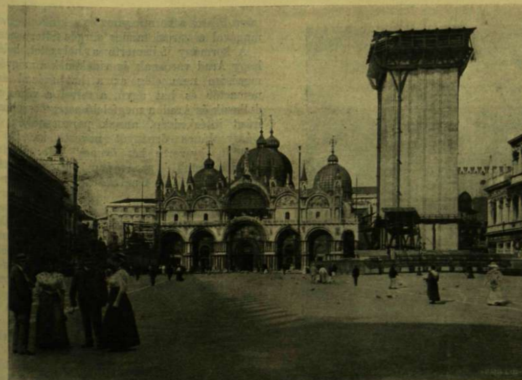
AZ ÚJ CAMPANILE ÉPÍTÉSE.
