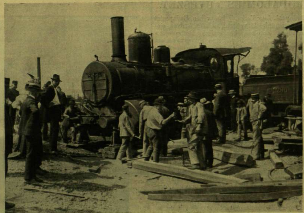
A KISIKLOTT VONAT MOZDONYÁNAK FÖLEMELÉSE.
