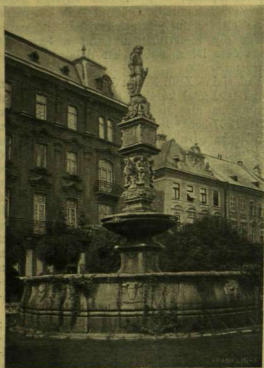
A POZSONYI VÁROSHÁZ TERÉN ÁLLÓ DÍSZKŰT.
