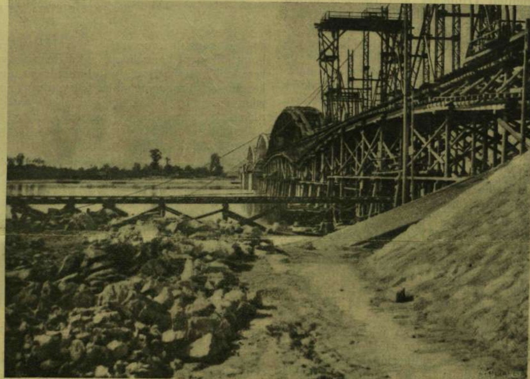
A Baja felőli szerelő-állvány.
