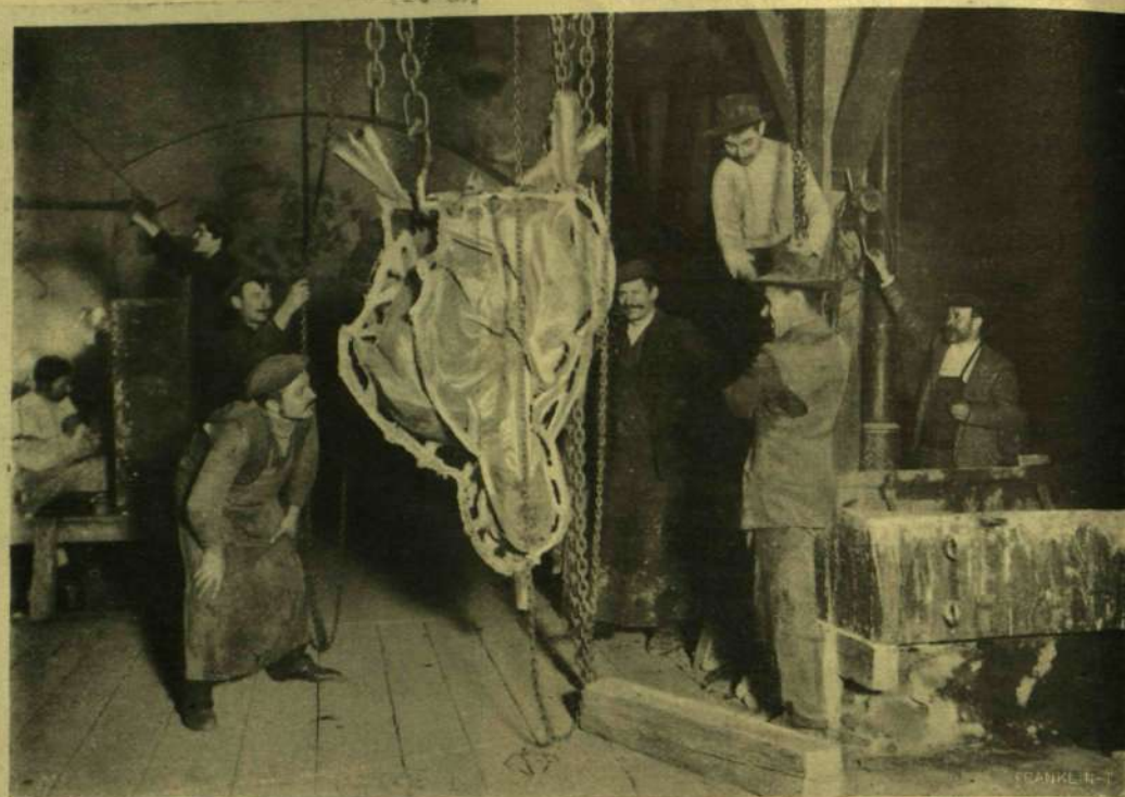
A KIÖNTÖTT SZOBROT KIEMELIK A FORMÁBÓL, LÁTHATÓK RAJTA AZ ÖNTŐ-CSATORNÁK, MELYEKEN AZ ÖNTÉSKOR A BRONZ BEFOLYT.
