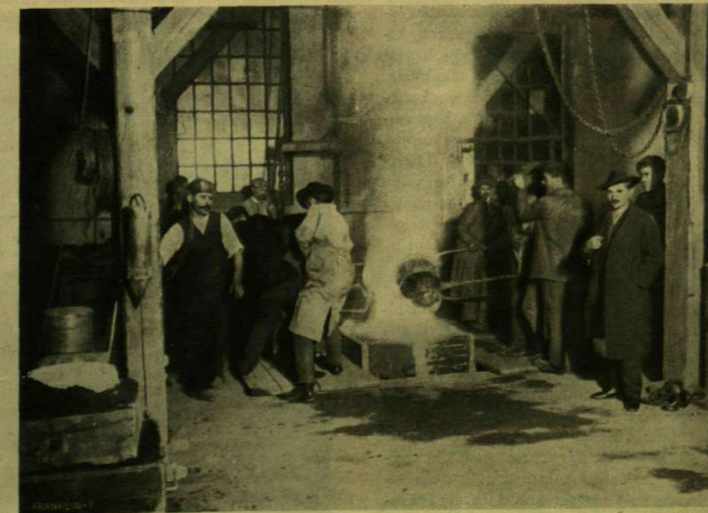
A BRONZ BELEÖNTÉSE A SÜLYESZTŐ GÖDÖRBE LEVŐ FORMÁBA.
