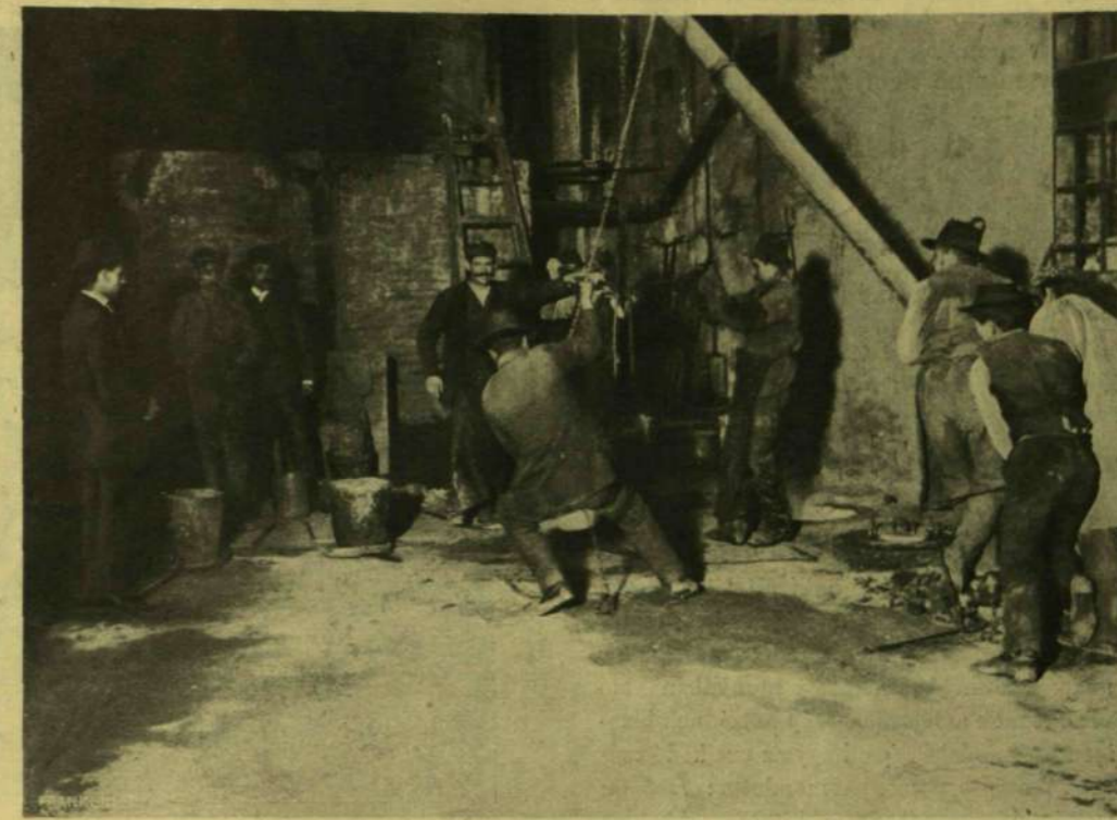
AZ 1200 FOKRA HEVÍTETT BRONZOT DARUVAL KIEMELIK AZ OLVASZTÓ KEMENCZÉBŐL.
