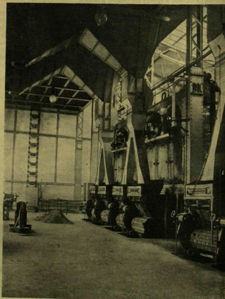
KAZÁNOK AZ AUTOMATIKUS SZÉNADAGOLÓ ÉS SALAKHORDÓ GÉPEKKEL.
