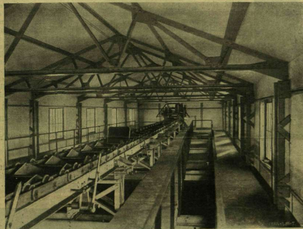
AZ ÚJPESTI FŐTELEP PADLÁSA A SZÉN SZÁLLÍTÓ AUTOMATÁVAL.
